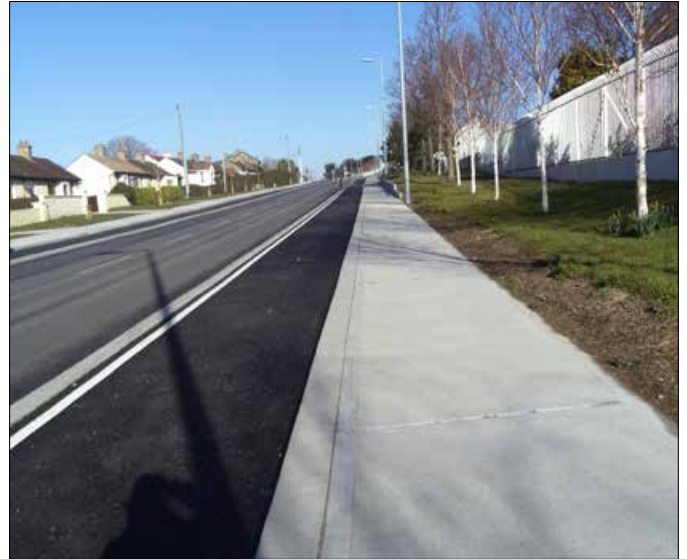
Scéim Feabhsaithe Bhóthar na Potaireachta tar éis na n-oibreacha
